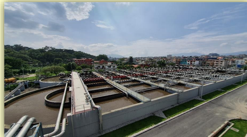
Guheshwori WTP, Nepal
